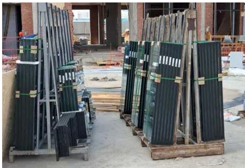
Рисунок 2 – Общий вид двухкамерного стеклопакета
