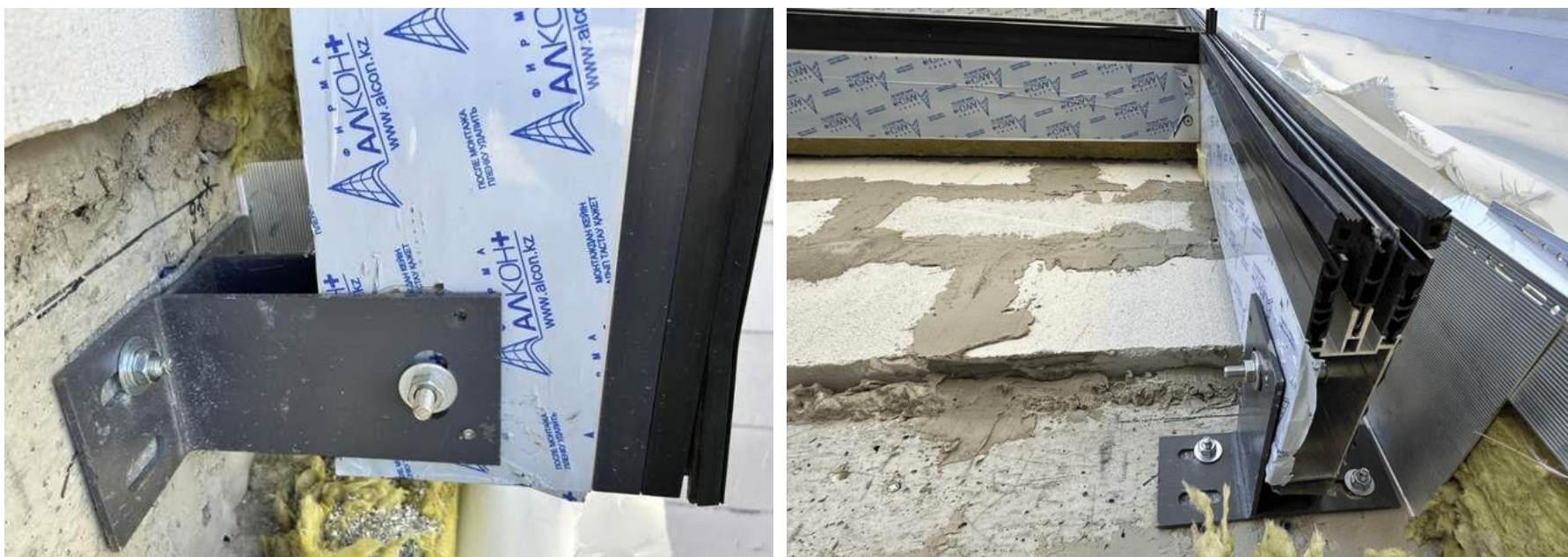
Рисунок 1.8 – Смонтированные кронштейны по плитам перекрытия
