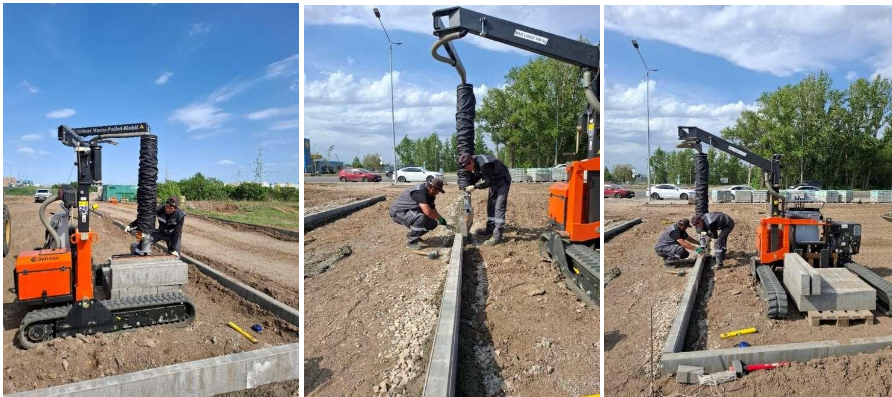
Рисунок 3- Установка бортовых камней механизированном способом
