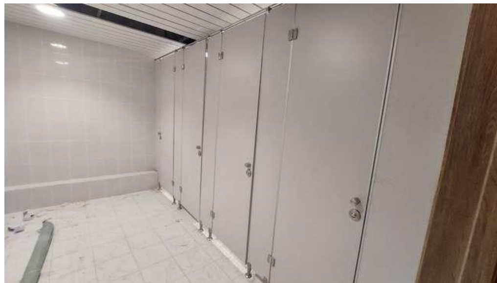
Рисунок 9 – Установленная сантехническая перегородка
