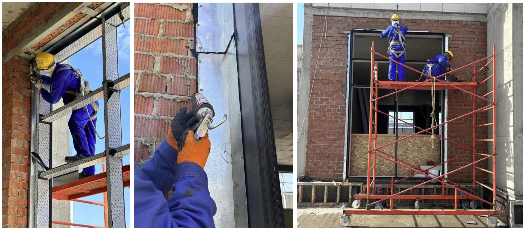
Рисунок 1.11 – Устройство противопожарной отсечки оцинкованной сталью периметра проема
