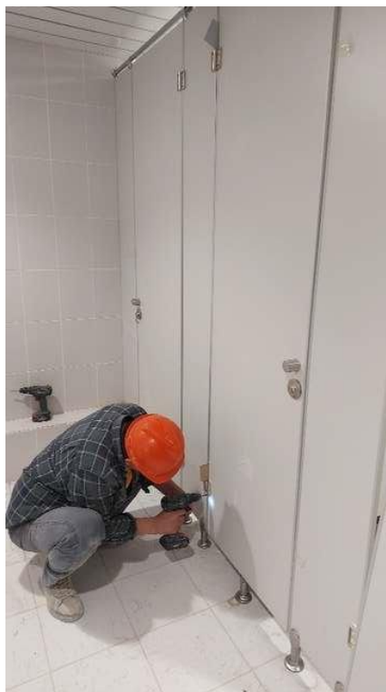
Рисунок 8 – Установка двери сантехнических перегородок
