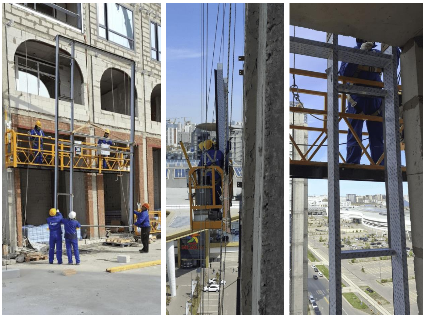
Рисунок 1.10 – Подъем и закрепление на кронштейны витражной рамы в проеме
