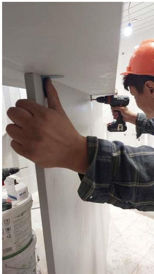
Рисунок 7 – Установка боковых и фасадных панелей сантехнических перегородок
