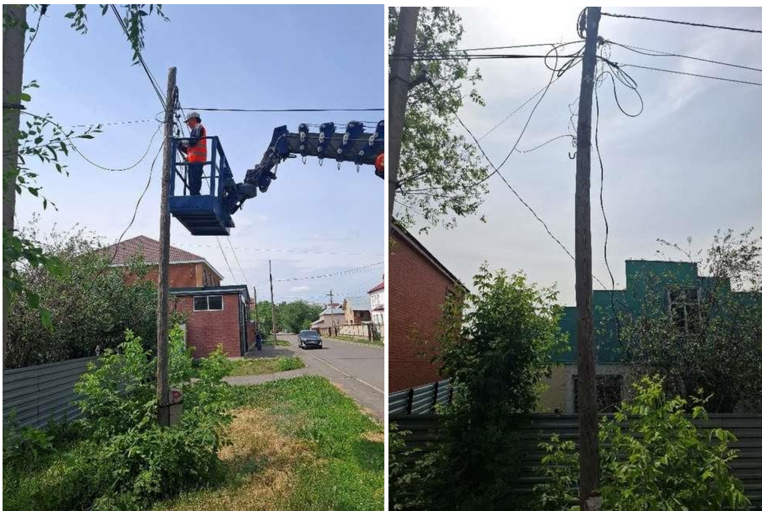
Рисунок 9 – Установка поддерживающего зажима
