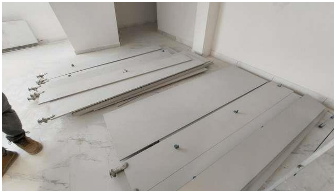
Рисунок 6 - Установка ножек и крепежных элементов
