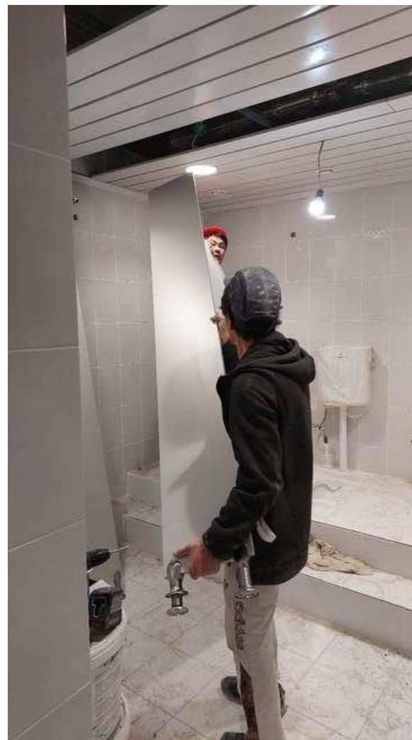
Рисунок 7 – Установка боковых и фасадных панелей сантехнических перегородок
