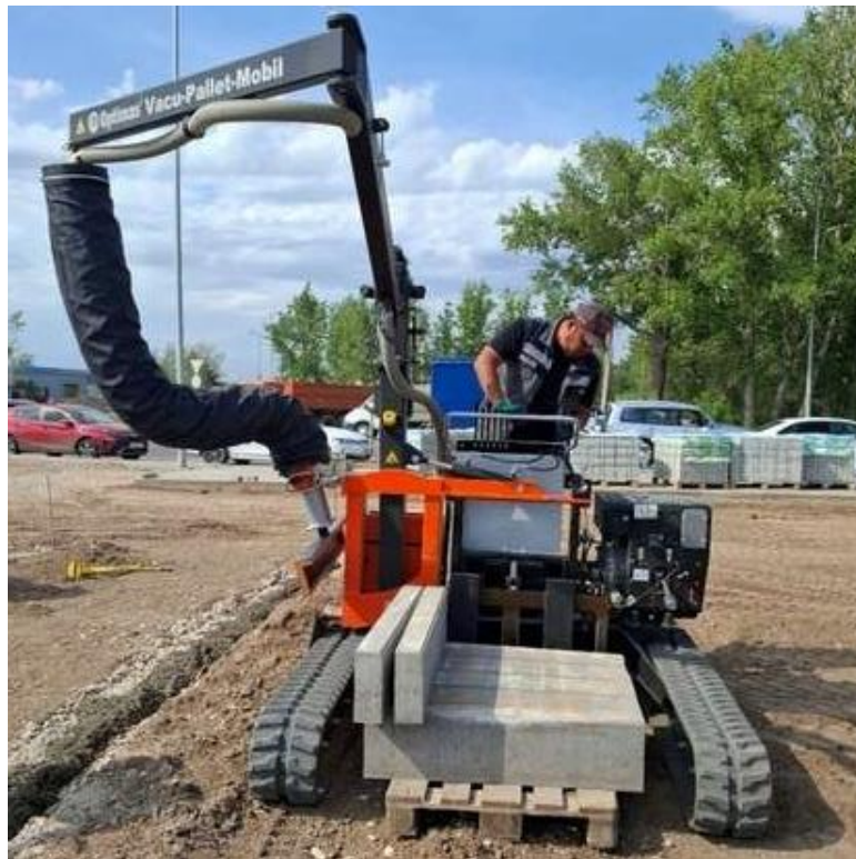
Рисунок 2 - Самоходная машина для укладки бортовых камней
