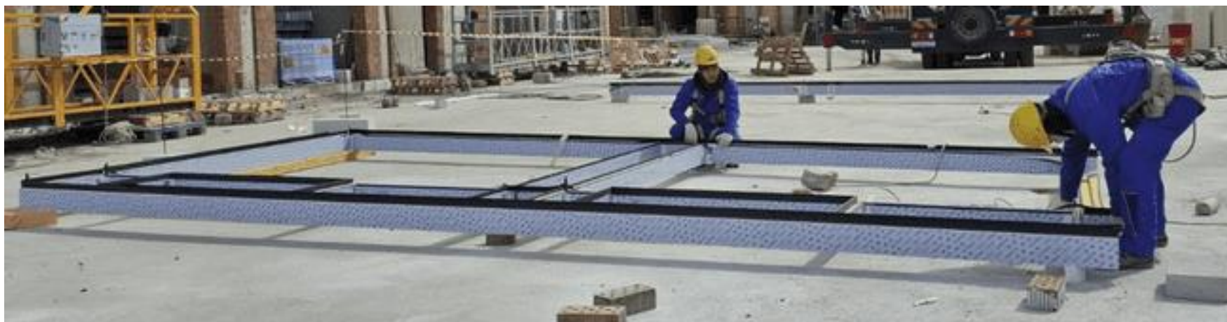
Рисунок 1.9 – Сборка рамы витражной
