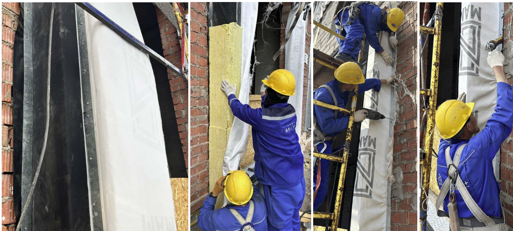
Рисунок 1.11 – Герметизация проема витражной рамы
