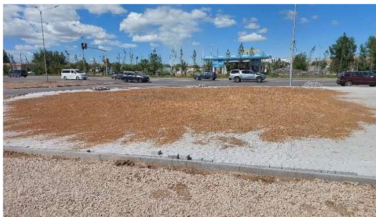
Рисунок 7 – Распределенная смесь песка
