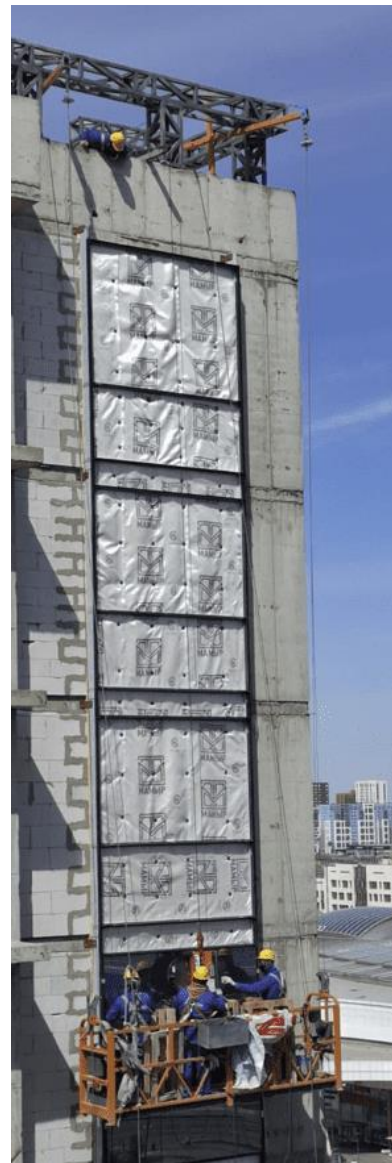
Рисунок 1.10 – Монтаж стеклопакетов
