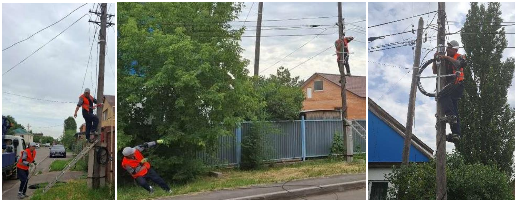
Рисунок 11 – Подвес кабеля на опоры
