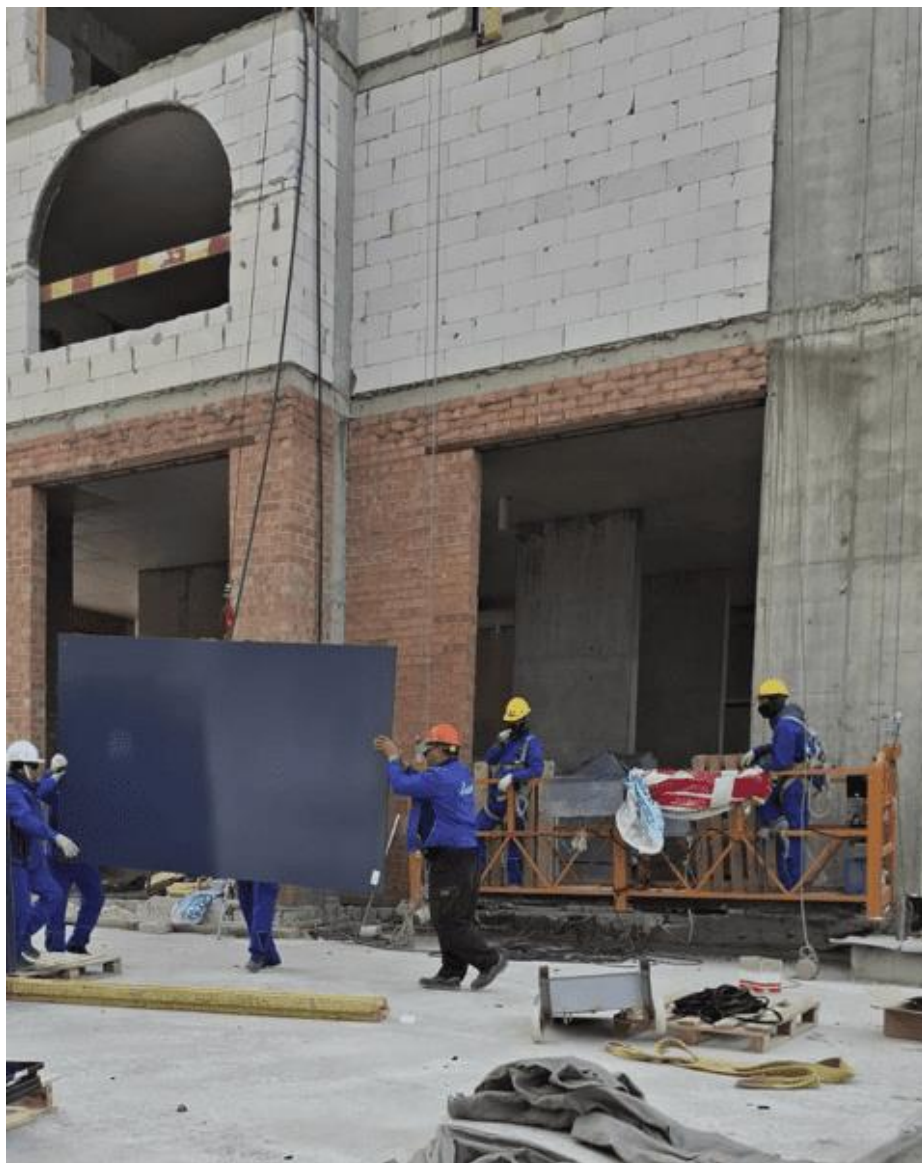
Рисунок 1.10 – Монтаж стеклопакетов
