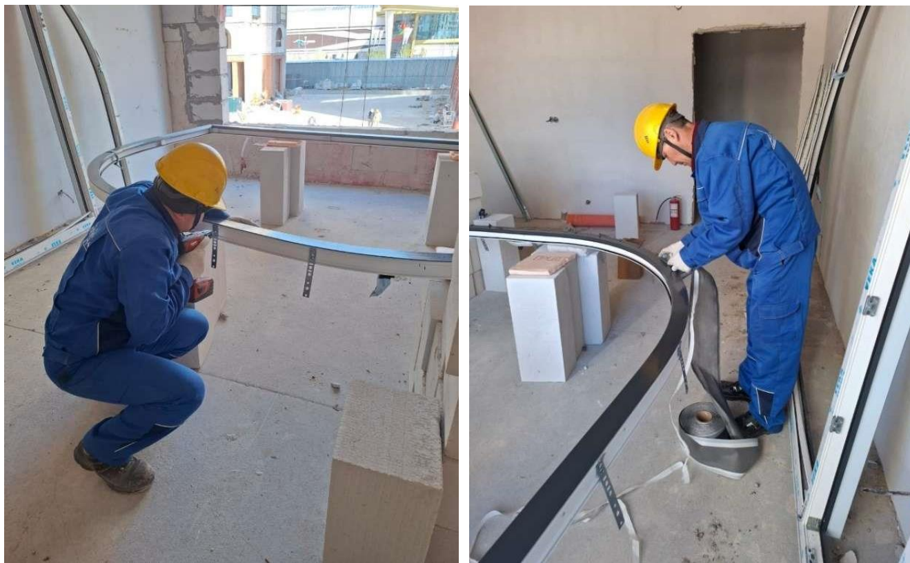
Рисунок 4 - Крепление анкерных пластин и проклейка уплотнительных лент
